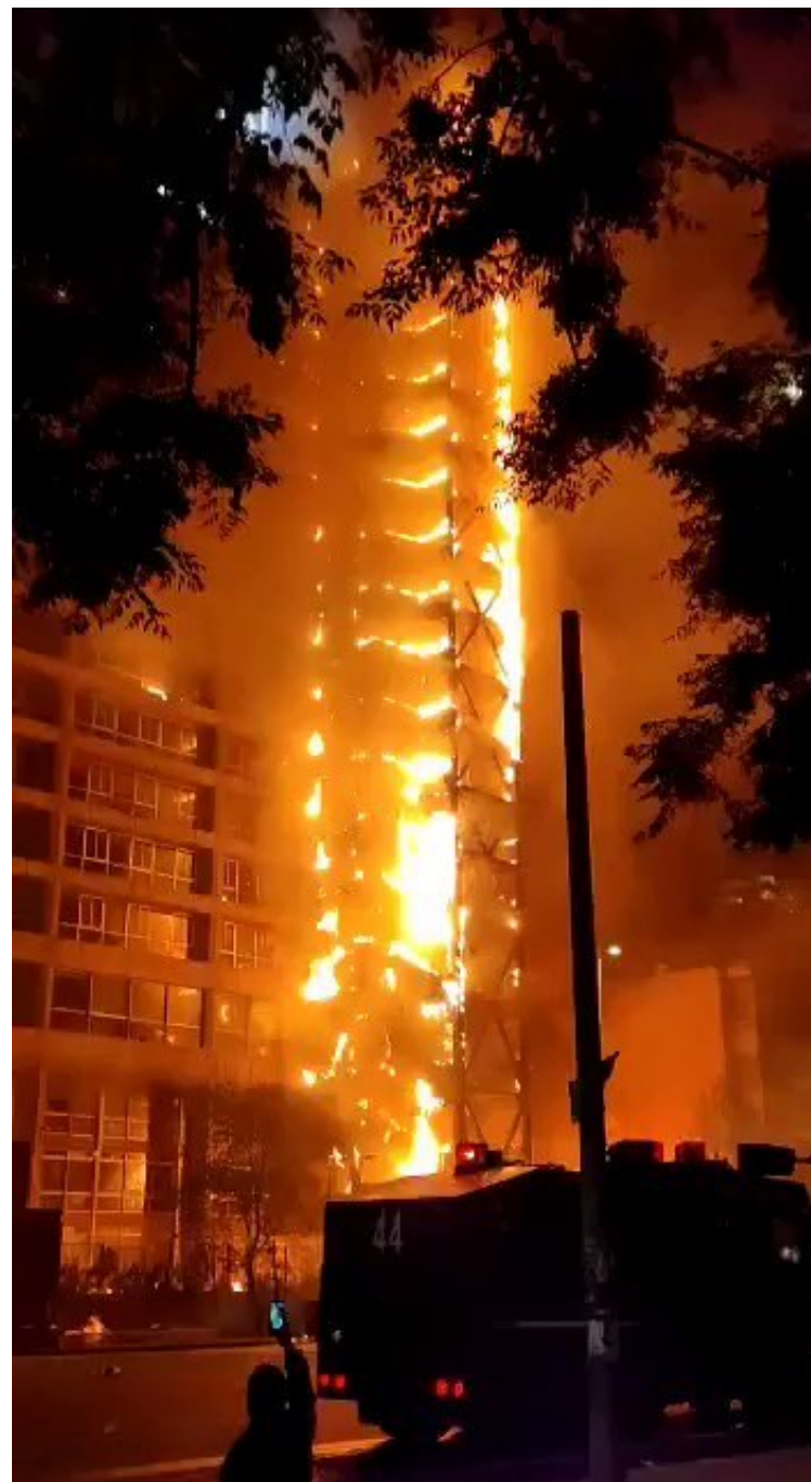
Incendio ENEL, 18 de octubre 2019. Santiago
